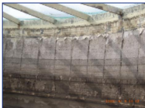
Derart beschädigte Behälter kann man gut retten durch Beschichtung mit einer Kunststoffolie. Natürlich nicht so elegant wie mit der o.g. anbetonierten Variante, aber ebenso effektiv.
