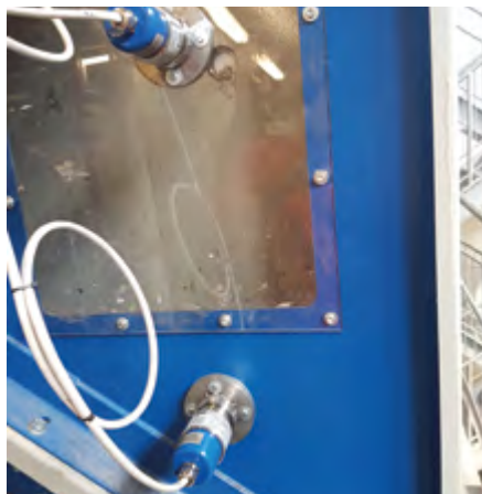
INSTALLATION IN EINEM BEHÄLTER
