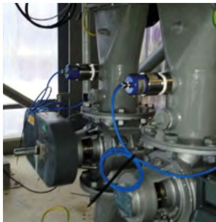
INSTALLATION IM FREIFALL NACH FÖRDERUNGEN
