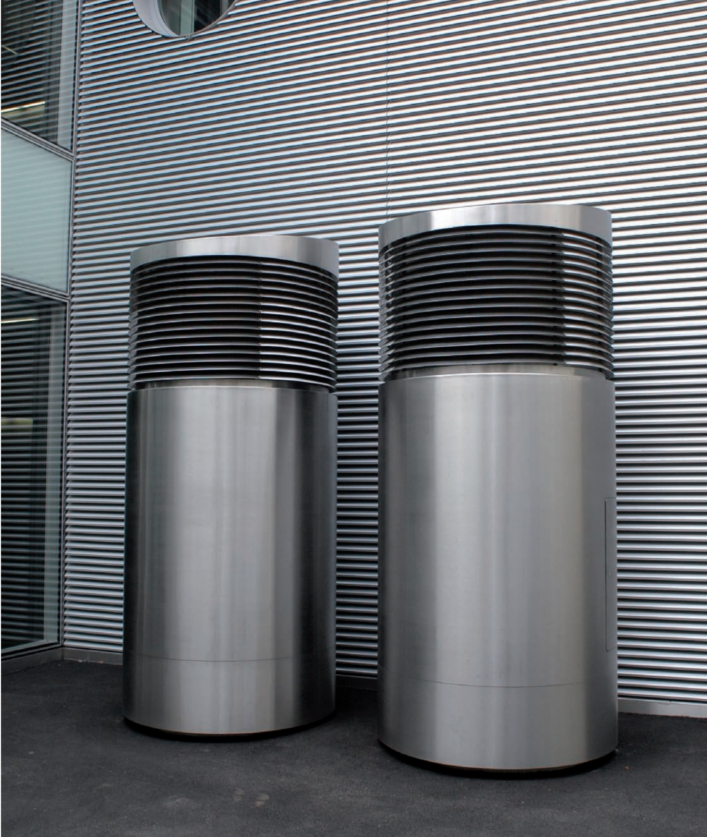
IWC Schaffhausen, 2009: Oberfläche geschliffen Korn 220, Kanten Überzahn frei, Lamellen mit CrNi-Leuchtplatten
