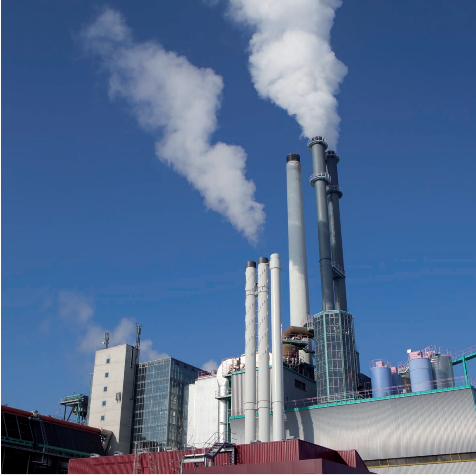
Erweiterung Kehrichtverbrennungsanlage Winterthur, 2009: Höhe 45m, DN 1200/1400, Innenrohr 1.4571, aussen statisch tragendes Stahlrohr lackiert, Berücksichtigung und Lösung bezüglich Interferenzen – Galopping zwischen den Kaminen
