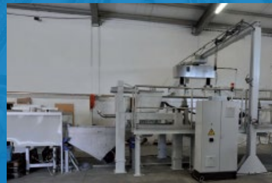
Bruch und Siebanlage
