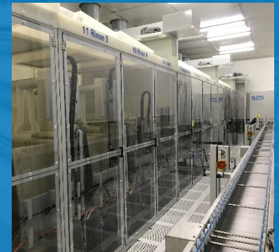
Ätzanlage im Reinraum
