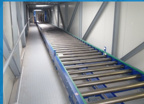
Rollenförderer auf Brücke
