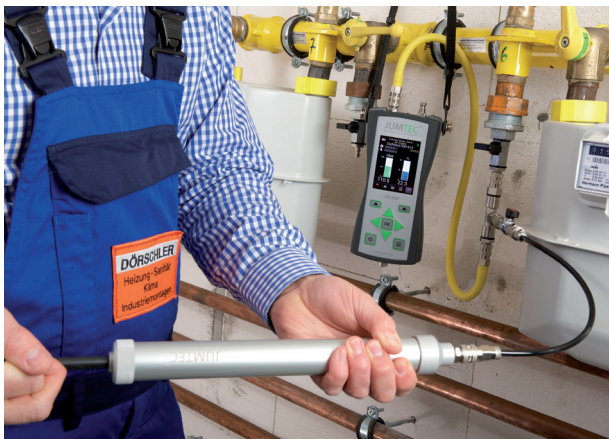
Dichtheitsprüfung 150mbar / Belastungsprüfung 1bar
