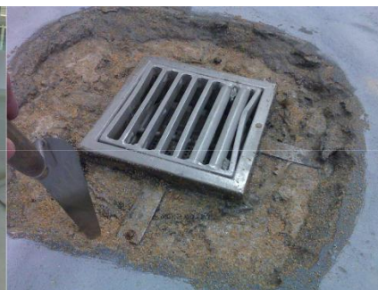
die Einläufe werden freigelegt
