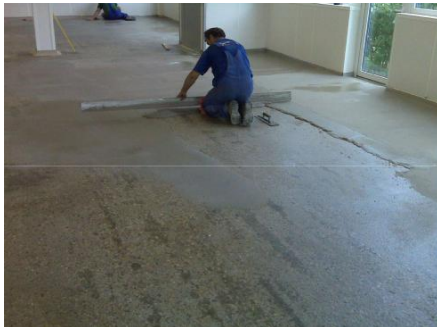
Gefälle wird eingebaut
