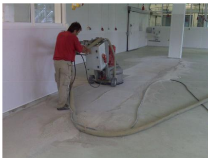
Abschleifen des EP Belages
