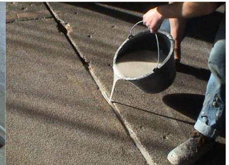
Fugen werden elastisch vergossen
