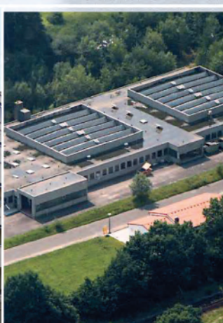
Produktionsstätte Henfenfeld Production site Henfenfeld
