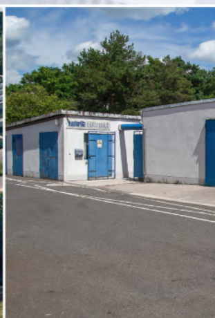
Produktionsstätte Hoyerswerda Production site Hoyerswerda
