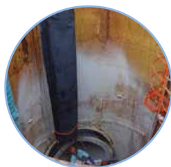
Einschieben einer gefalteten kissenförmigen Rohrblase
