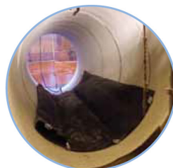
Positionieren – kissenförmige Rohrblase sollte horizontal positioniert werden
