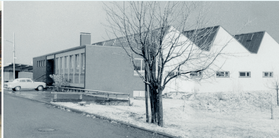
Neubau 1963 in Großheppach im Remstal
