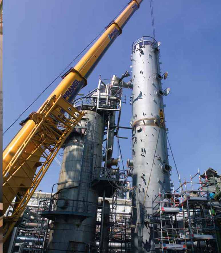
Montage eines Druckbehälters / On-site erection of a pressure vessel
