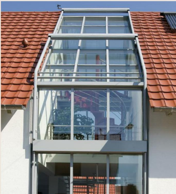
Eine Einheit aus Glasdach und Glasfassade. Dieses Treppenhaus gliedert den Baukörper und macht den Funktionsraum zum Erlebnisraum.
