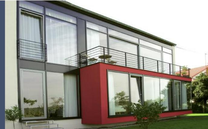
Ein Neubau auf dem Areal eines Reiterhofs. Hier sollte über zwei Geschosse der Blick in den Garten und auf die umliegenden Feuchtwiesen geöffnet werden. Realisiert wurde dies mit einer Pfosten-Riegel-Konstruktion mit einem großen Parallel-Schiebekipp-Element.
