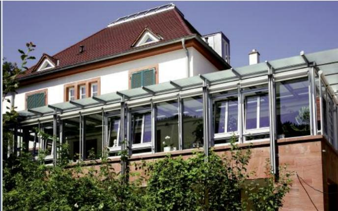
Ein frei stehendes Wohnhaus aus dem Jahr 2003, frei auch der weite Blick aus der großzügigen Verglasung. Die nasslackierte Stahlkonstruktion mit eingesetzten Aluminiumelementen spricht eine moderne und dabei zeitlose Formensprache.
