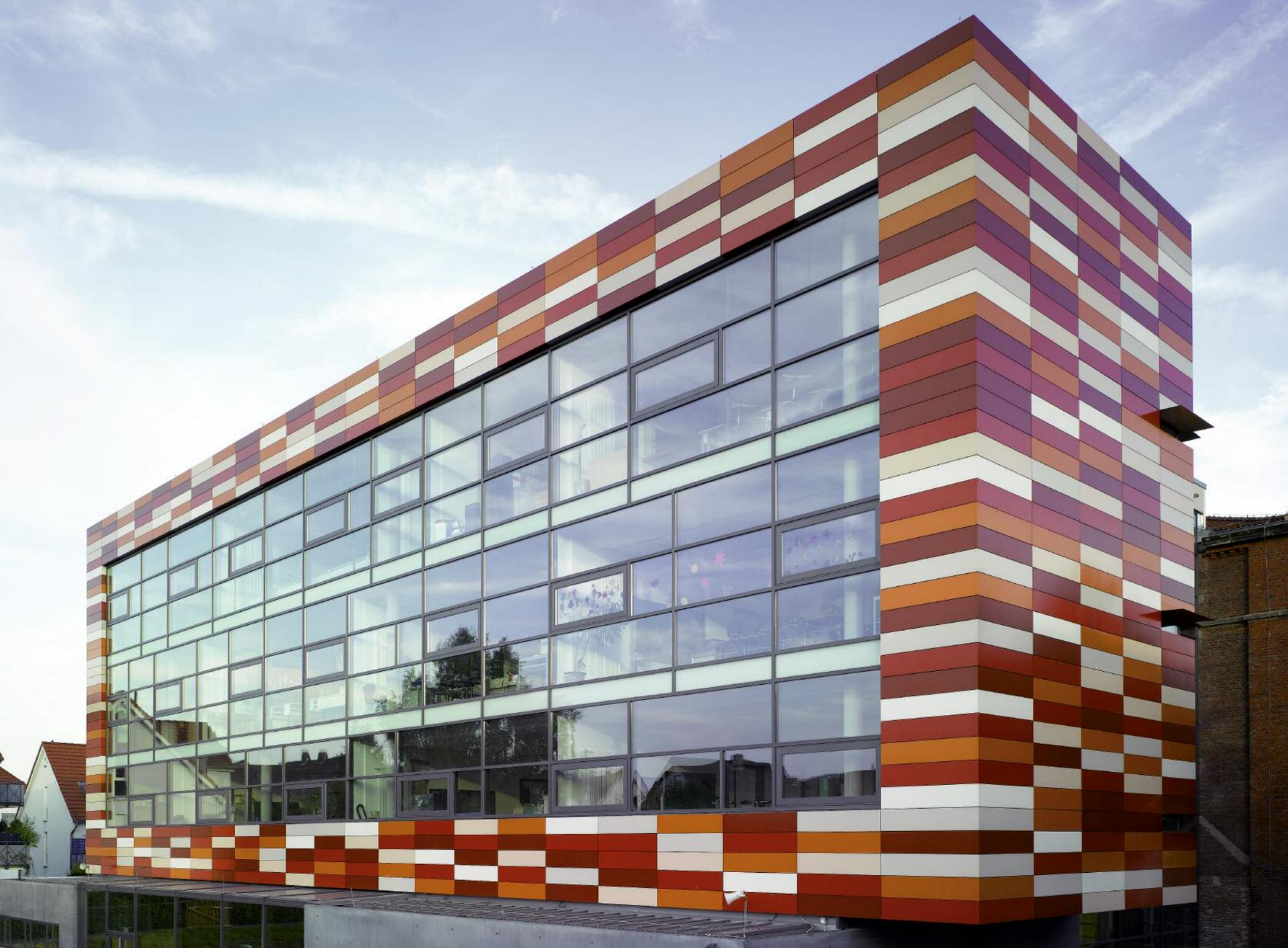
Die Brüder-Grimm-Schule in Hofgeismar nach ihrem Umbau 2005/06: Nord- und Südseite des Gebäudes sind ausgestattet mit Pfosten-Riegel-Fassaden im System Jansen-Viss-Basic mit absturzsicherndem Glas. Ein Stahl-Glasdach im Format von 14 x 14 Metern überspannt den Innenhof. Der Eingangsbereich zu Aula und Speisesaal ist als Wintergarten ausgeführt.
