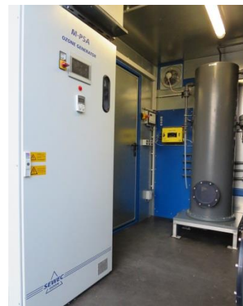
VA Tech WABAG Wien; Versuchsanlage zur Abwasserreinigung CSB Entfernung mittels Ozon
