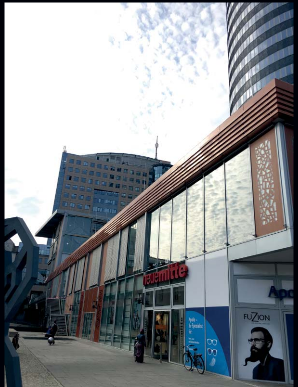
Aluminium Lamellen als Designelement und Werbeträgerkonstruktion. Insgesamt 7 Tonnen und ca. 2000 Meter lang an einer Glasfassade befestigt. Hier: Neue Mitte Jena
