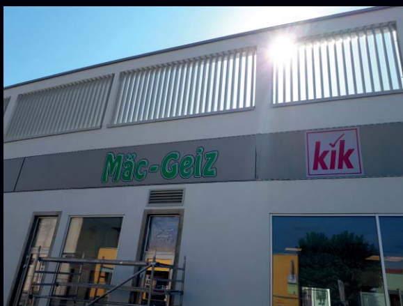
150 Meter Leuchtkasten mit PVC Spanntuch und eine Bautiefe von 65mm. Vollflächig mit LED beleuchtet. Obere Reihe: Aluminium Lamellen als Designelement und Absturzsicherung. Hier: Das Zschasch Einkaufscenter Dresden
