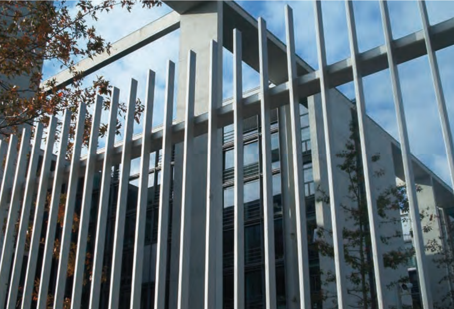
Vorgesetzte Flacheisenprofile sorgen für optimale Stabilität und Übersteigschutz
