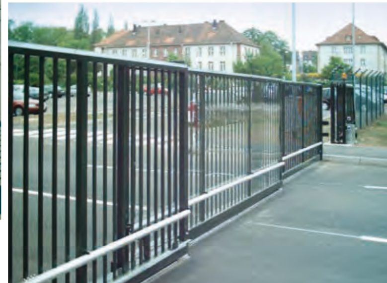
Bodenlaufende Teleskoptore können bis zu 4-teilig ausgeführt werden
