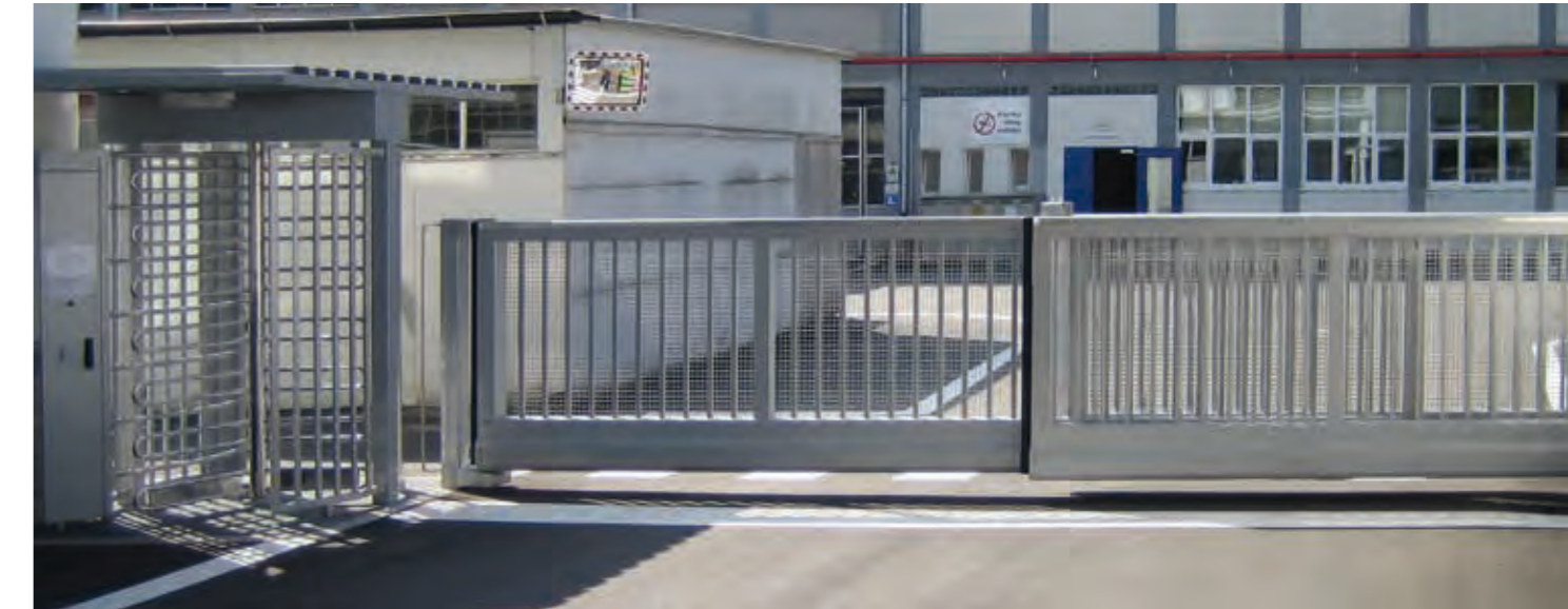
Als Durchgreifschutz werden die Torflügel mit Punkschweißgitter, Lochblech oder Acrylglas hinterlegt
