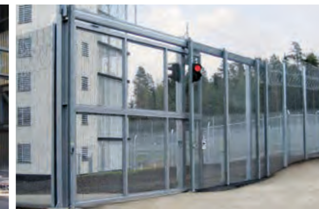
Ist keine Bodenführung möglich, können die Torflügel auch hängend gelagert werden
