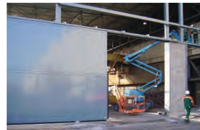
Sonder-Schiebetor mit Sonderfüllung für maximalen Schallschutz
