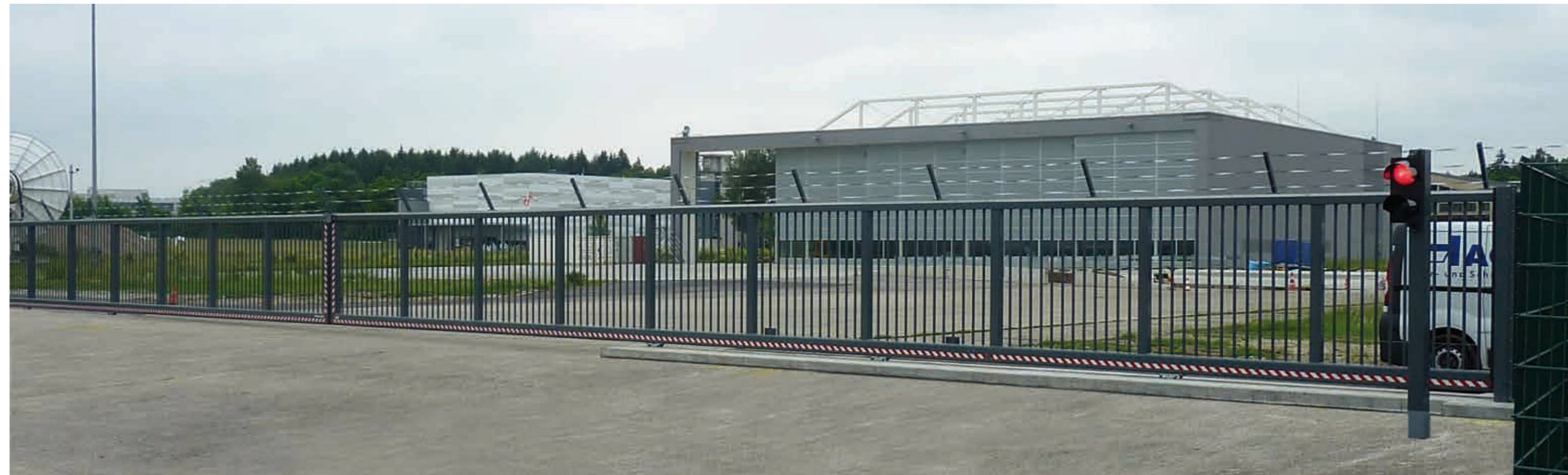
2-teilige Schiebetoranlage. Übersteigschutz mit Nato-Stachelband
