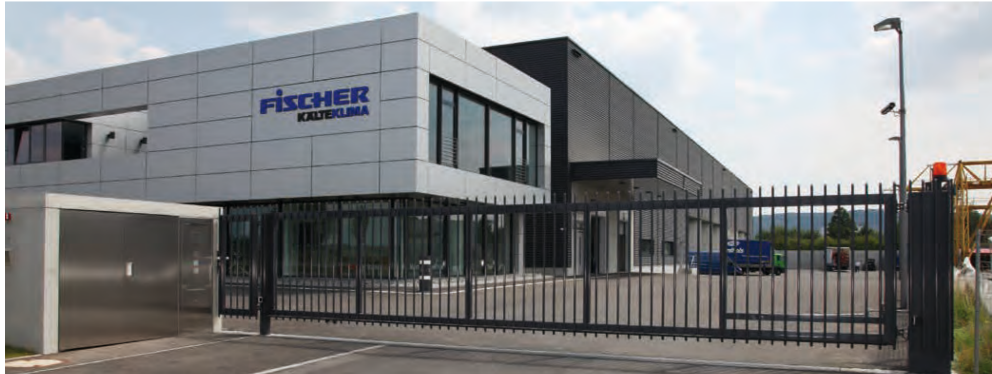
1-flügelige Toranlage mit aufgesetzten und überstehenden Rundrohr-Füllstäben
