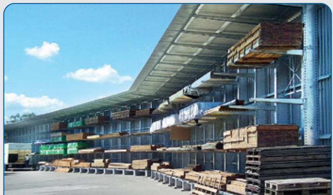
Freitrageregale als Holz- und Baustofflager mit Dach- und Wandeindeckung
