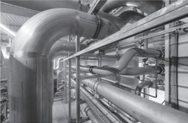
CENTUM® ist die ideale Lösung für den Rohrleitungs- und Anlagenbau. Schwere Lasten, wie sie beispielsweise bei großen Rohrdimensionen vorkommen, werden sicher und zuverlässig abgefangen.
