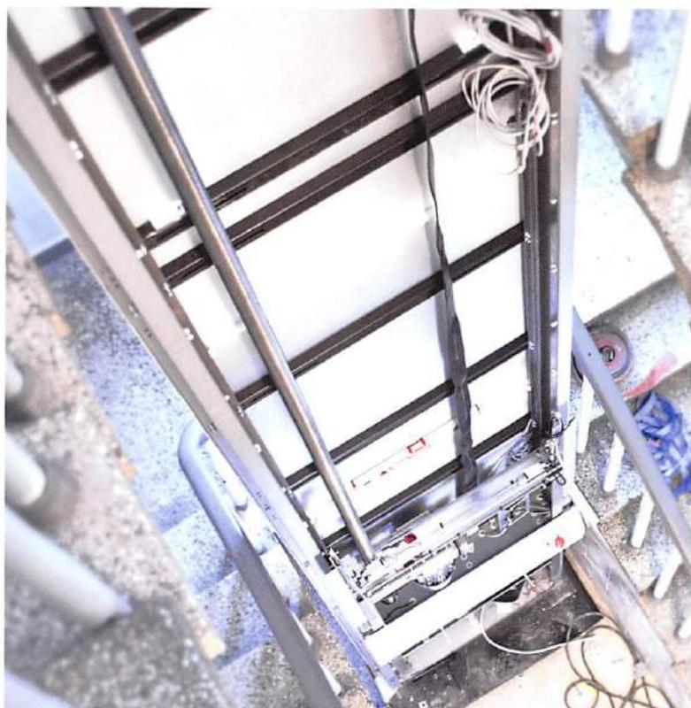
Niemand möchte gerne eine Baustelle im Haus haben. Beim Einbau eines Ammann & Rottkord-Aufzugs ist das auch gar nicht nötig. Da wir für die Installation unseres Liftes keinen Schacht und keine Grube brauchen, und die meisten Teile komplett angeliefert werden, sind die Einbauzeiten in der Regel sehr gering.
