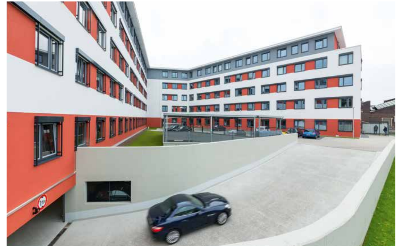
Verwaltungsgebäude, Neuss Perfekte Ergänzung: Tiefgarage in Stahlbetonbauweise mit Modulgebäude.
