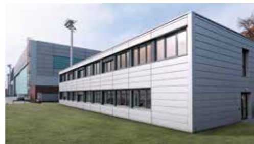
Wunstorf , 2-geschossiges Bürogebäude, BGF 870 m 2
