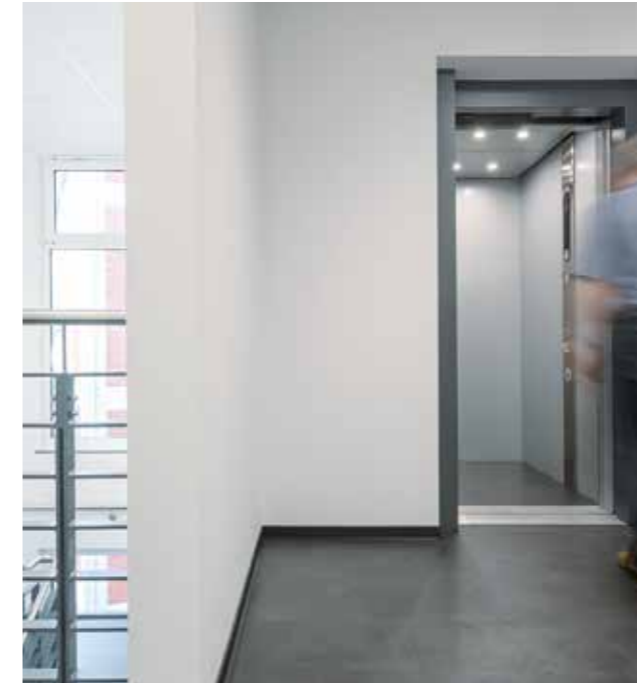
Aufzug, EnBw, Stuttgart
