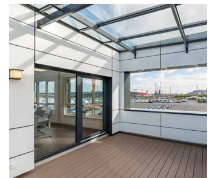
Dachterasse, Bürogebäude Heinrichs, Bremerhaven
