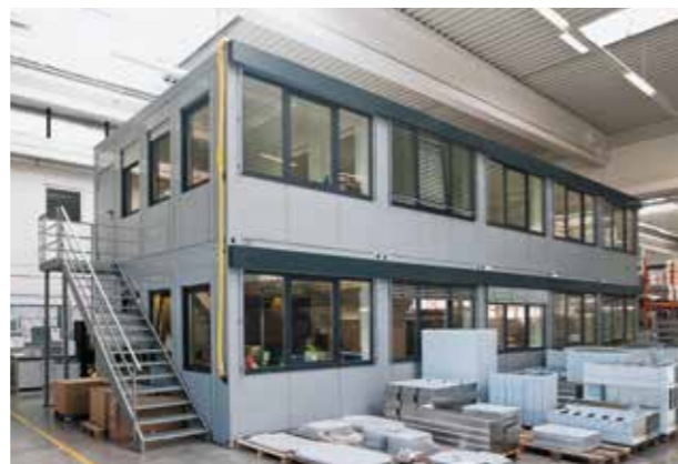
Halleneinbau als zusätzliche Bürofläche
