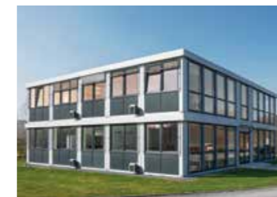
Fassade mit anthrazit lackierten Kassetten unterhalb der Fenster
