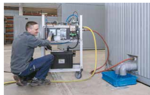
Sanitäreinheiten durchlaufen eine Desinfektion des Rohrleitungsnetzes gemäß Trinkwasserverordnung.
