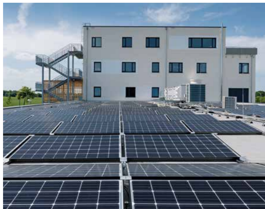
Photovoltaikanlage, Nieren- und Diabeteszentrum, Viersen
