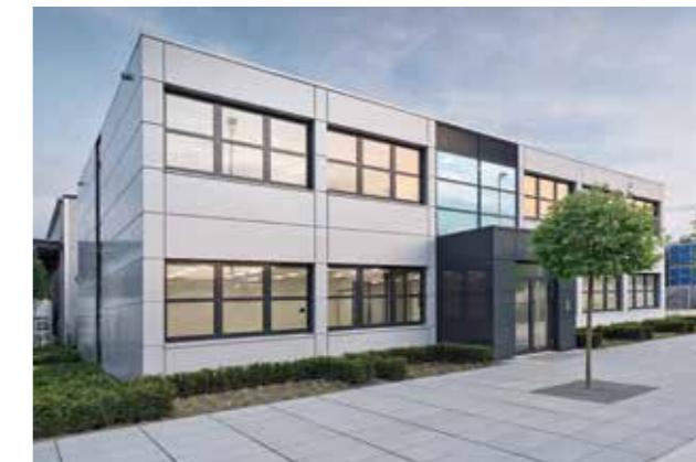
Das Bürogebäude vor der Aufstockung.
