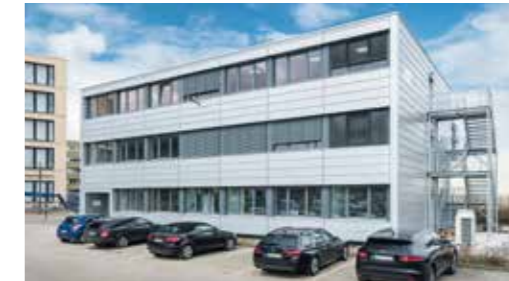
Kornwestheim , 3-geschossiges Bürogebäude, BGF 830 m 2
