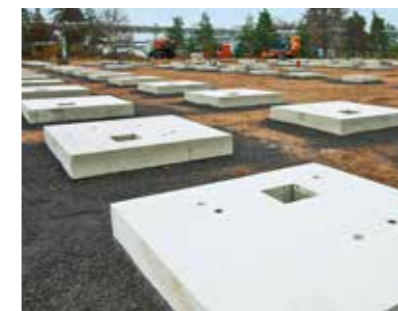
Fundamentierung mit Beton-Fertigteileplatten
