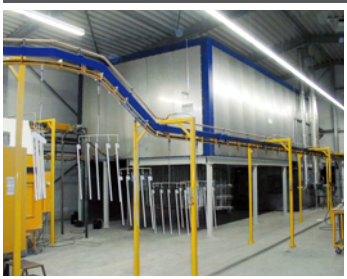
Automatische Durchlauf-Pulverbeschichtungsanlage. Der Pulverbrennofen ist als A-Ofen ausgeführt. Der Transport erfolgt mittels Kreisförderer.
